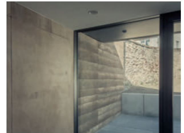
Der pigmentierte Sichtbeton im Saal fungiert als optische Verlängerung der alten Friedhofsmauer und schafft so eine Verbindung zwischen Innen und Außen.
