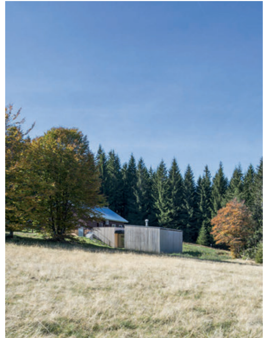
Radionuklidstation, Hofgrund: Der homogene neue Baukörper mit seiner unbehandelten Holzfassade und zurückhaltenden Architektursprache fügt sich sehr gut in das Landschaftsbild ein und bewirkt gleichzeitig eine deutliche Aufwertung der Gesamtanlage.
