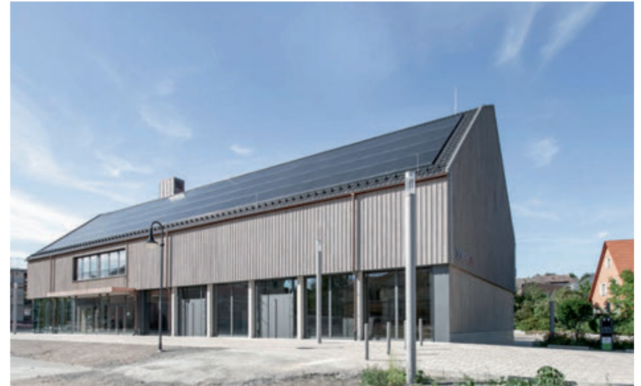
Durch den Bau des neuen Dorfhauses, das mit seinen unterschiedlichen Funktionen vielfältig nutzbar ist, entsteht eine neue Ortsmitte.
