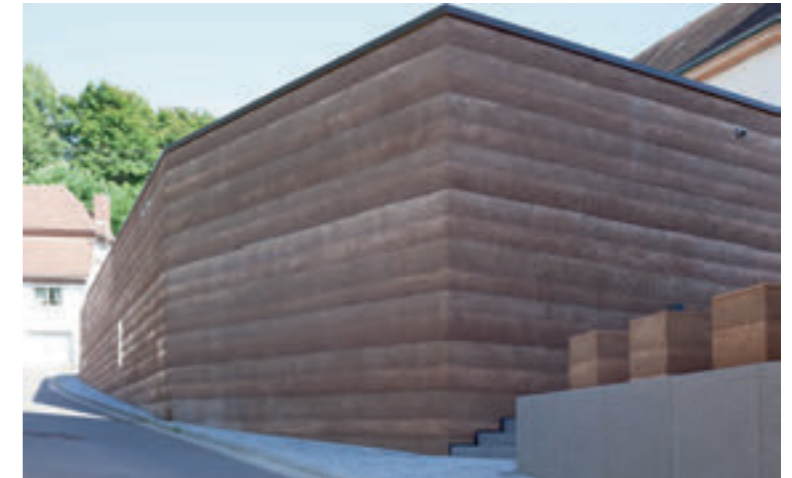
Die Fassade aus Stampfbeton lässt das Gemeindehaus wie eine Verlängerung der alten Mauer aussehen.
